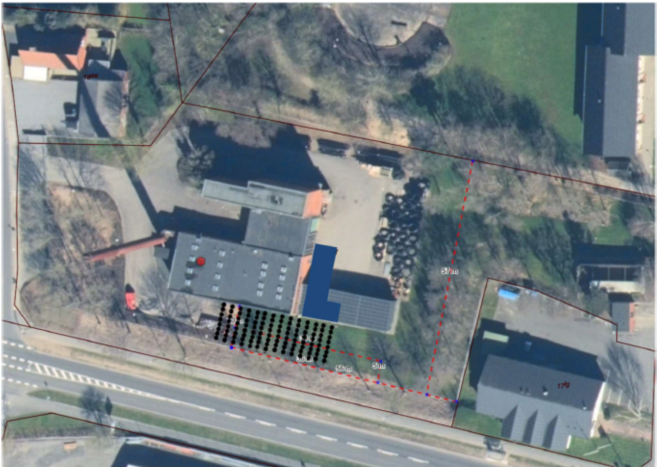
Figur 5.3 Luftfoto af bygningen hvor varmepumperne placeres, som viser hvordan fordamperne/varmeoptagerne ligger ift. bygningen. Det blå rektangel illustrerer kompressorbygningens placering.
