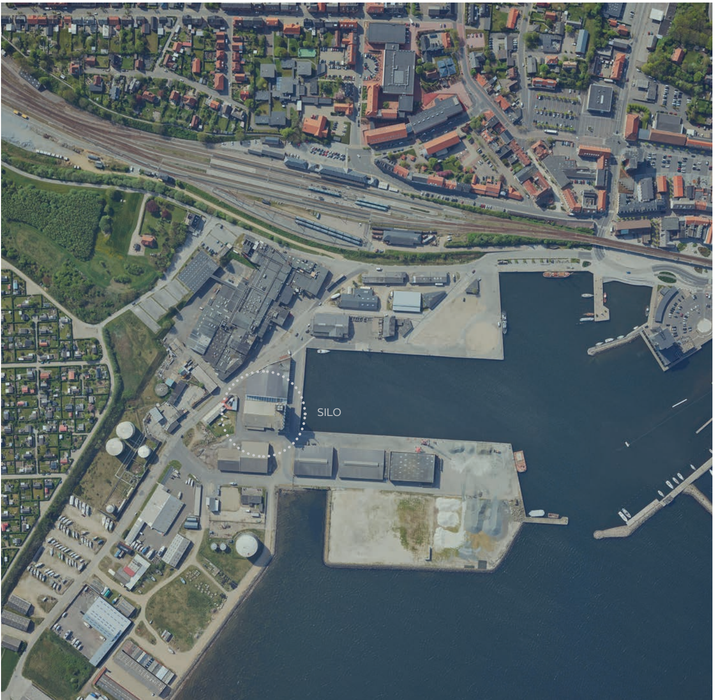
Oversigt Nordkajen, Sydkajen og SILO - Struer Havn
