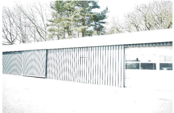
#2 Garage syd for område med tidl. afværgetiltag.
