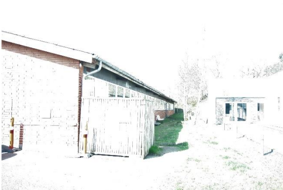
#11 Nordside af bygning.
